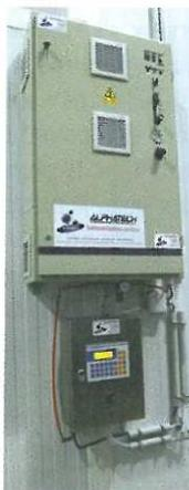
Générateur d'ozone pour le traitement d'ambiance des pièces de travail et de stockage. Le réseau est installé préférentiellement dans les faux plafonds. L'armoire abrite deux lampes haute fréquence (1 400 volts) qui portées à incandescence génèrent de l'ozone (O<sub>3</sub>). Un automate régule la production.
